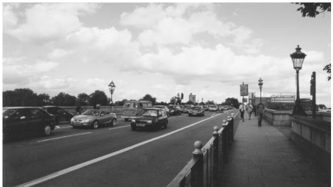
図 - 4 パットニー・ブリッジ 2002年9月撮影
