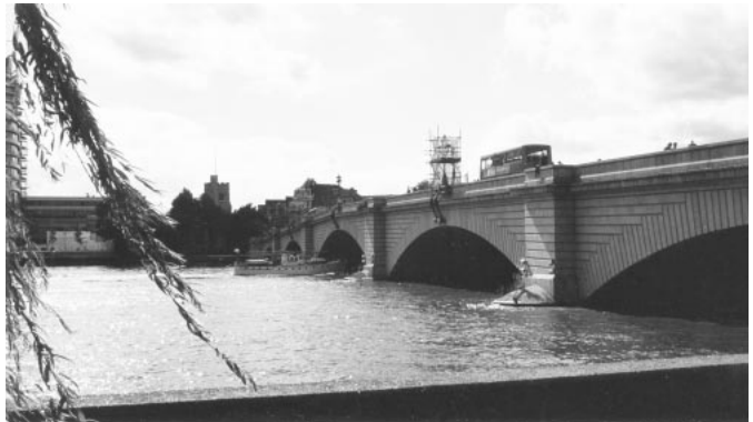
図 - 3 パットニー・ブリッジ 2002年9月撮影
