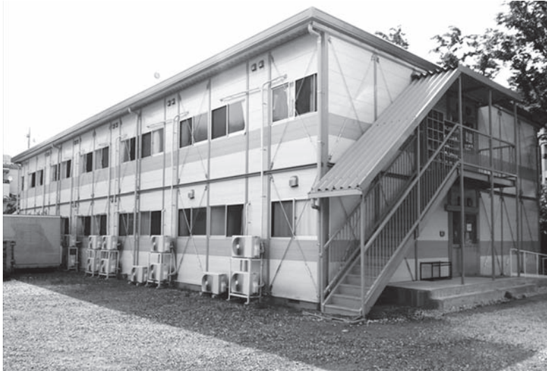
現在のクラブハウス（部室）
