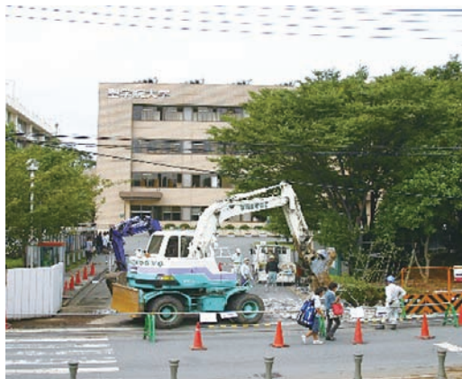
2004年頃 旧正門解体工事
