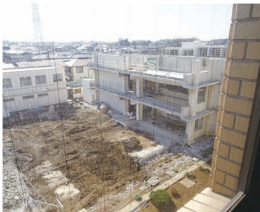
1号館解体工事
