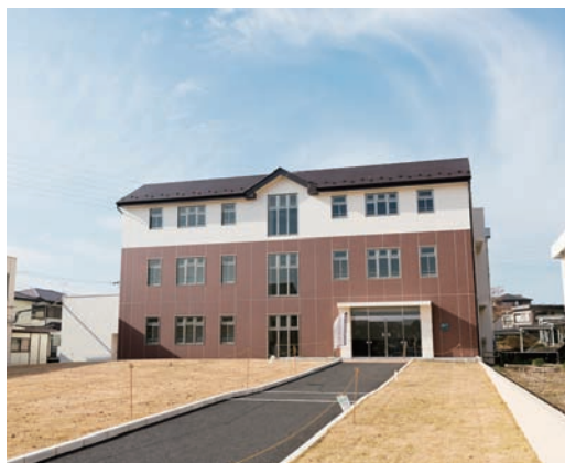
現在の1号館前
