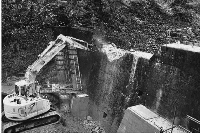
図 11 治山用のダム*の撤去工事（2009年10月27日読売新聞） （*群馬県みなかみ町赤谷川支流の茂倉沢 治山第2堰堤）
