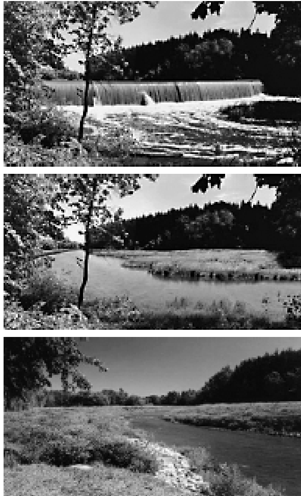
図9 図・写真 コンピューター・シミュレーションを用いた ダム撤去前後景観比較
