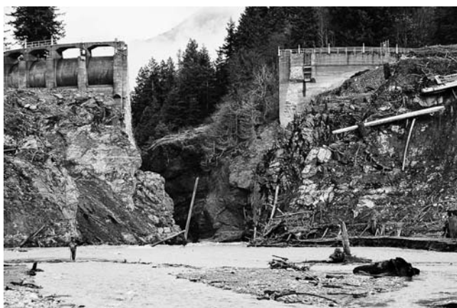
図1 グライnz・キャニオン・ダム 右岸部撤去 貯水池底から下流を見
