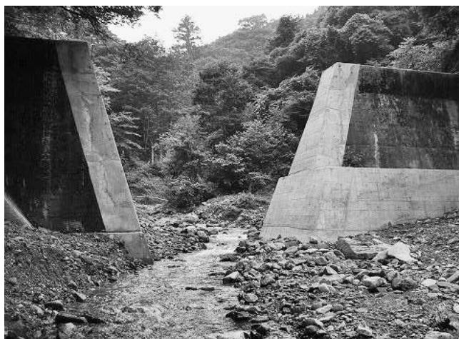
図2 群馬県 赤谷川支流茂倉沢2号堰堤 ダム中央部撤去
